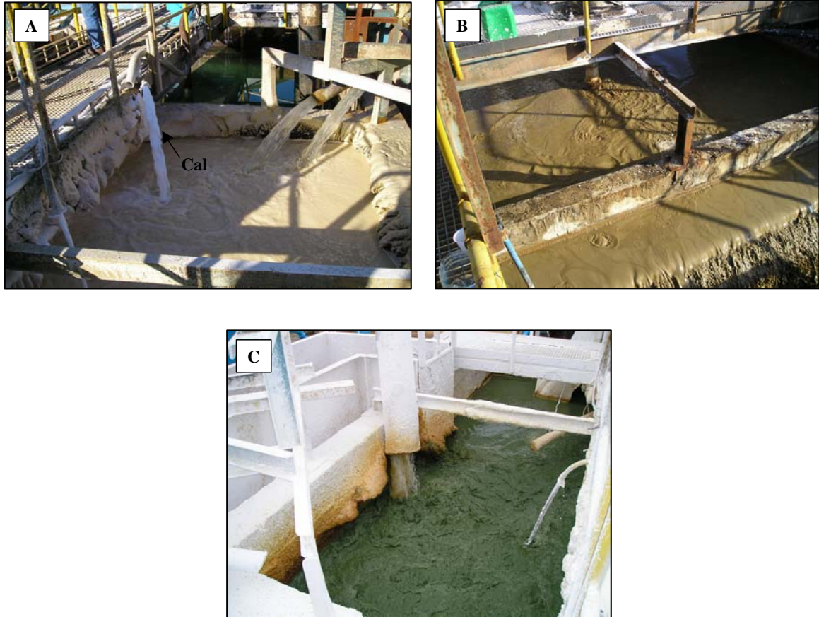
Figura 9.8; Planta de tratamiento de agua de Aznalcóllar (tanque de mezcla/agitación). El color del lodo refleja la evolución de las características químicas del agua de la corta. A) Marzo de 2005, con muy escaso Fe disuelto, B) Septiembre de 2006, con 770 mg/l de Fe (mezcla de Fe(II) y Fe(III)), y C) Noviembre de 2006, altas concentraciones de hierro (~1.000 mg/l) exclusivamente como Fe(II).
