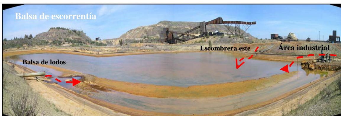
Figura 9.6. Balsa donde se recogen las aguas de minas generadas en diversas zonas del emplazamiento minero.
